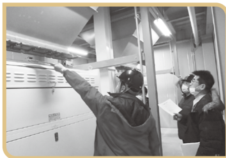
深川市職員による完了検査
